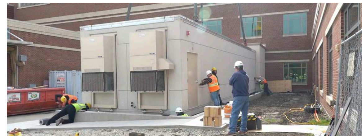
Installation sur une dalle adjacente aux bâtiments existants
