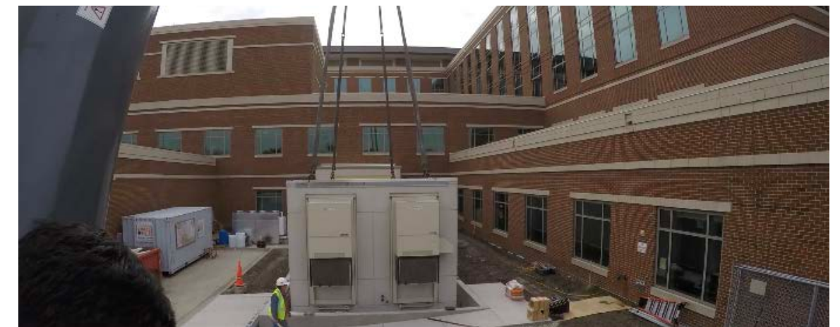
Installation par grue
